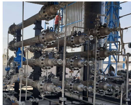
Membrane module assembly
