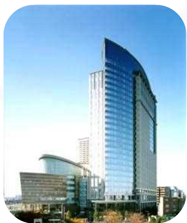
NEDO Head Office (Kawasaki, Kanagawa)
