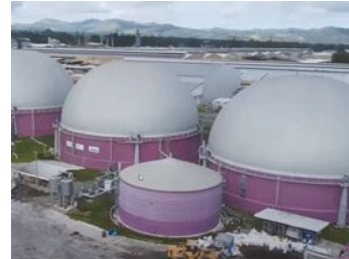
バイオガス発電(フィリピン) /伊藤忠商事
