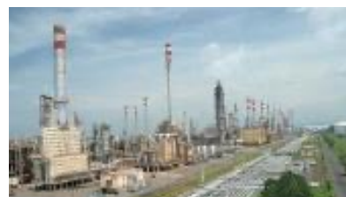
石油精製プラントの運転制御最適化 (インドネシア) /横河電機
