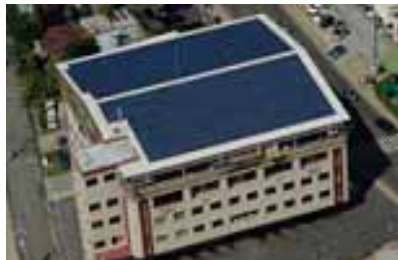
太陽光発電 (パシフィックコンサルタンツ) 太陽 光パネル: 京セラ製
