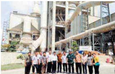
セメント廃熱回収発電 (JFEエンジニアリング)
