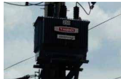
高効率アールパス変圧器 (裕幸計装) アールパス金 属: 日立金属製
